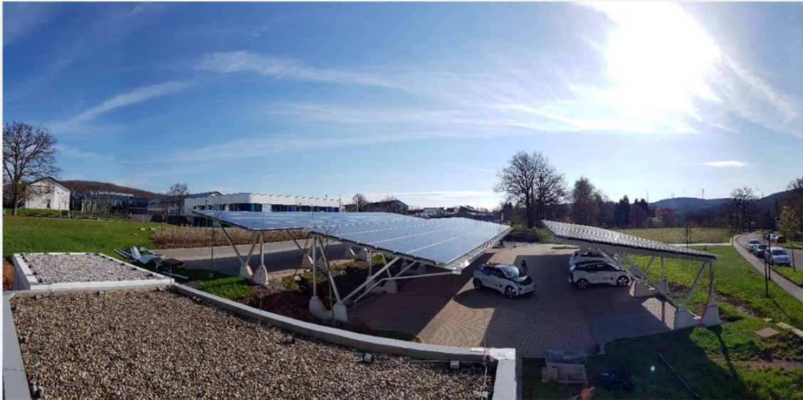
PV-Carport am Umwelt-Campus Birkenfeld (Quelle: IfaS)
