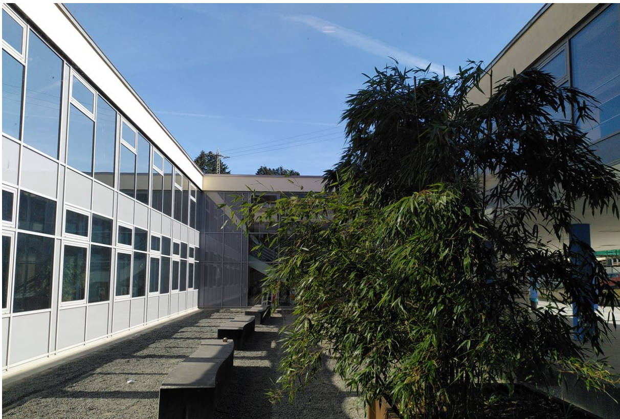
Abbildung 4-2 Innenhof des Schulgebäudes des Siebenpfeiffer-Gymnasiums
