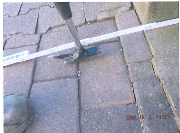
PFLASTER ABGESACKT
