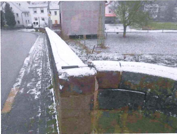
BRÜSTUNG ÜBER PFEILER VERSCHOBEN
