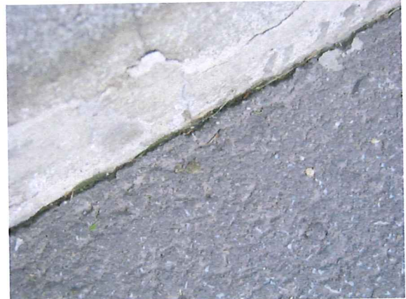
LAENGSFUGEN FEHLEN
