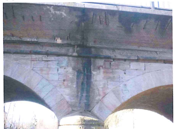
MAUERWERK DURCHFEUCHTET
