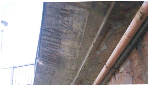
BETONABPLATZUNG
