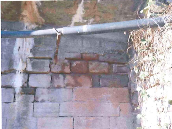
FUGENMÖRTEL HERAUSGEBROCHEN
