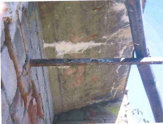
KONSOLE DURCHGEROSTET
