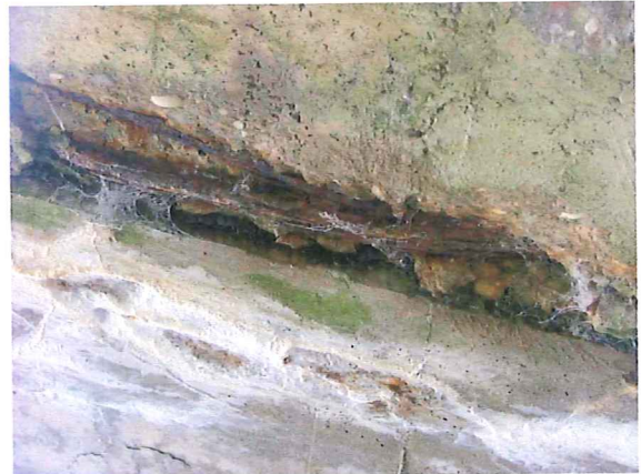
BEW VERROSTET MIT QUERSCHNITTSSCHWÄCHUNG
